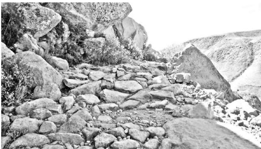
FIGURA 2 Camino Real de Potosí adoquinado en las cercanías de Hospicio, al occidente de la Huaylilla, comuna de Arica
