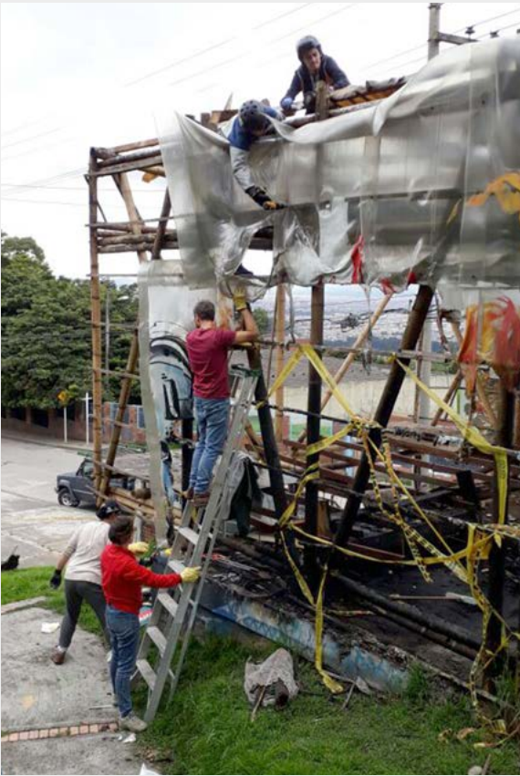
Figura 4: Proceso de desmontaje de la Casa del Viento. Fuente: Elaboración propia, 2017.
