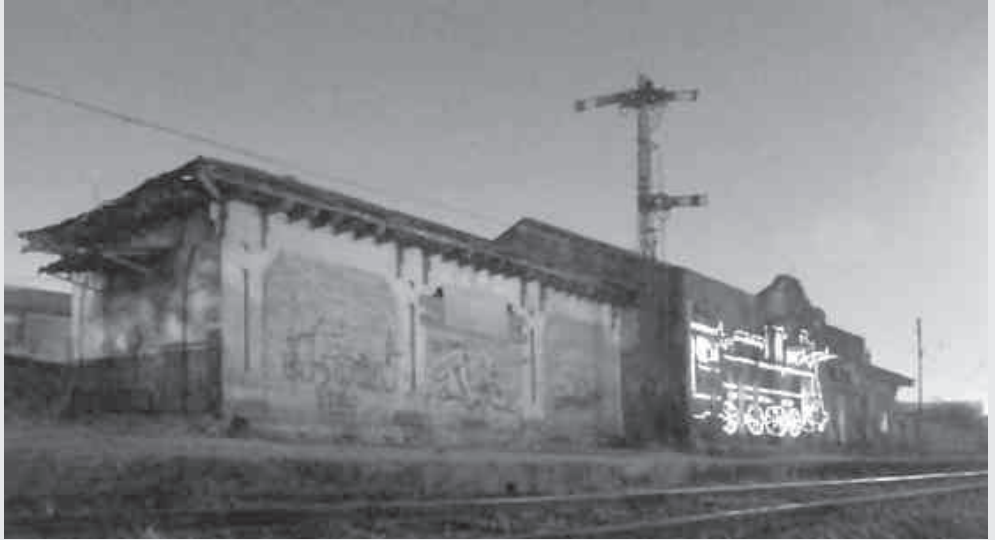
Estación Andalién en la actualidad. Fotografía de Luciano Pérez.
