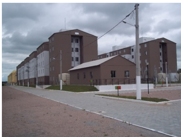
Figura N° 1 Residencial Montevideo, Labore Ingeniería Ltda.
