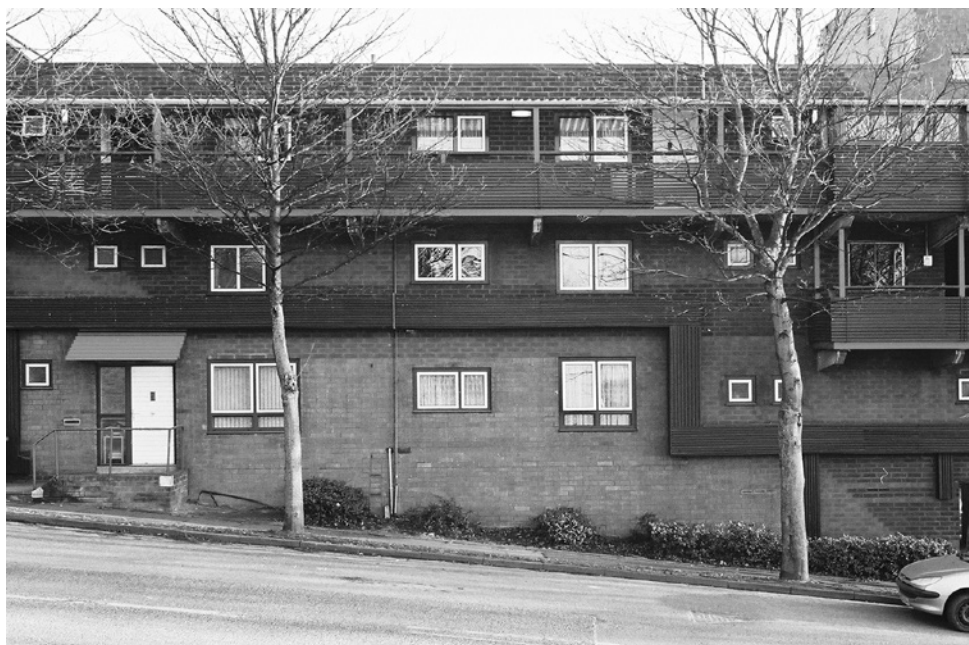
FIG. 09: Fachada de Salisbury House, del área Dunn Terrace, sobre la calle Byker Bank (2012). Foto: Julián Varas.
