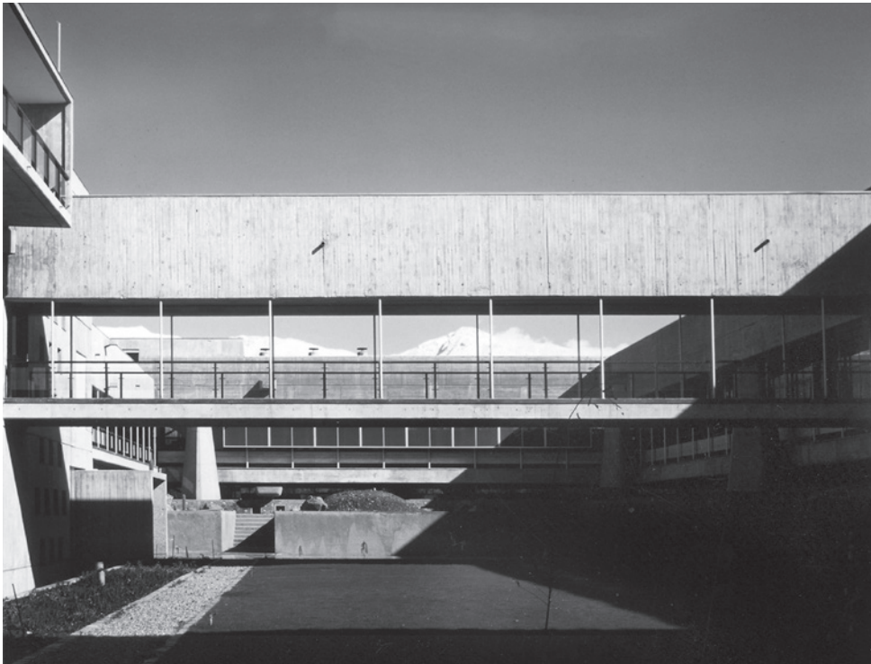
FIG. 17: Vista de uno de los puentes y los patios al finalizar la construcción. Foto c. 1966. Fondo Emilio Duhart, Archivo de Originales FADEU UC.
