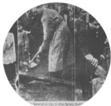
Colocación de la primera piedra, 1955
