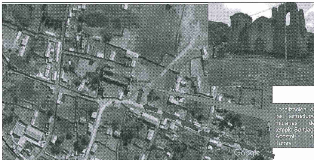
Imagen 02: Imagen panorámica del área de estudio destaca las estructuras murarias del templo, la foto pone en evidencia la fachada parcialmente colapsada (lado derecho).
