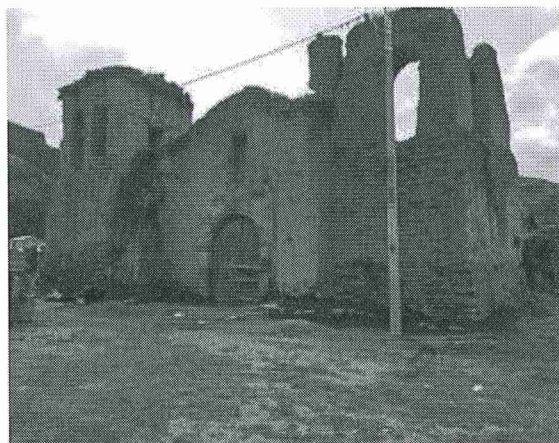
Fachada de Pies estructuras murarias del Templo Santiago Apóstol
