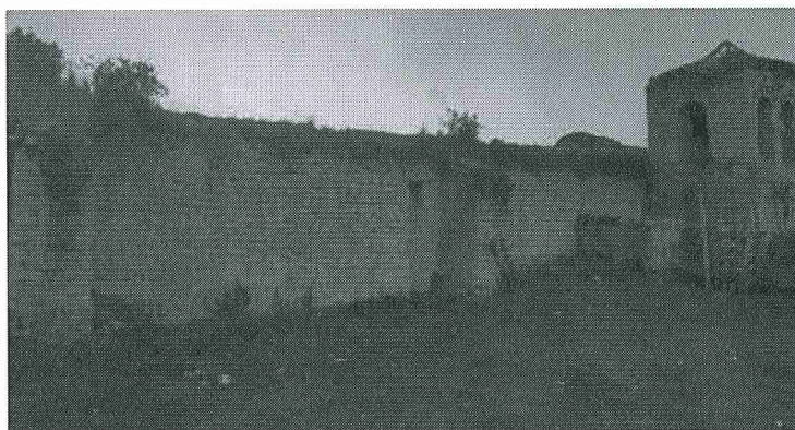
Vista de la fachada lateral izquierda o muro del Evangelio
