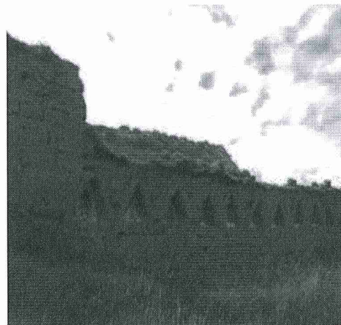
Una fracción del cerco perimetral o barda y muro de la puerta, nótese sus características.
