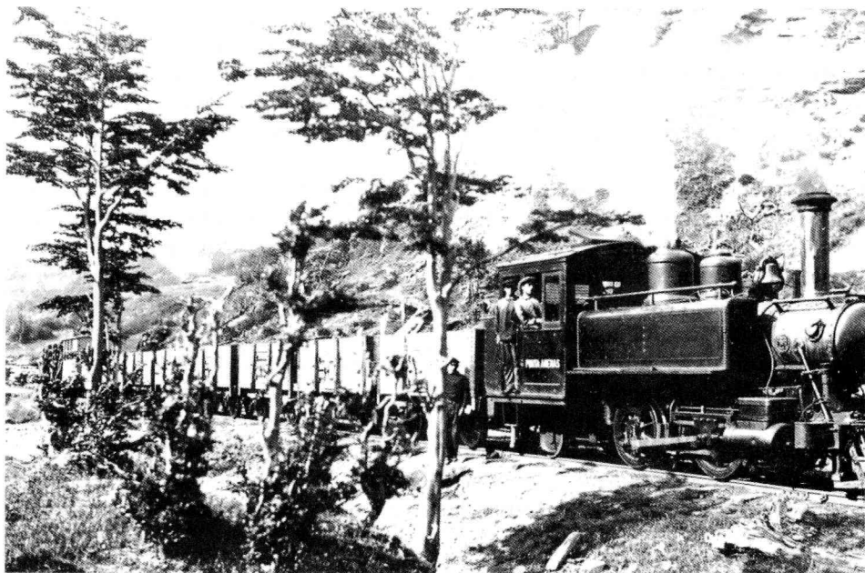
Ferrocarril de la mina Loreto transportando carbón. Fotografía hacia 1930.
