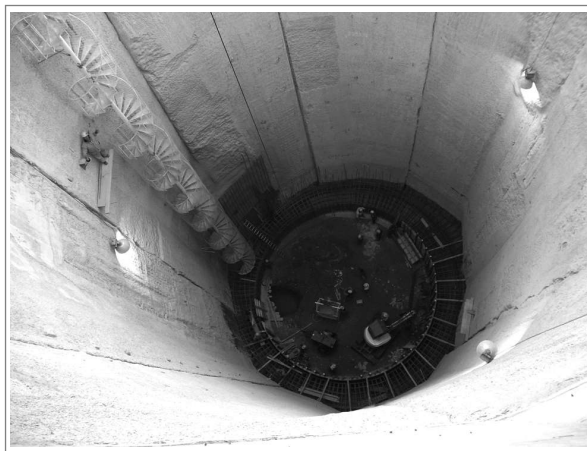
Figura 1. Aspecto de una lumbrera, de 12 m de diámetro y 40 m de profundidad (fuente propia) Figure 1. Shaft appearance, 12 m diameter and 40 m depth (own source)
